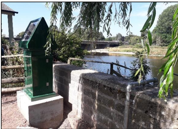
Ffigur 7: Mesurydd uchder newydd yn y Clas-ar-Wy, Powys. Roedd yr hen giosg wedi'i leoli yn is na'r lefel ar gyfer digwyddiad llifogydd 1 mewn 100 mlynedd ac yn cael ei bweru gan drydan o'r prif gyflenwad. Gwnaeth Cyfoeth Naturiol Cymru ail-leoli'r ciosg fel ei fod ar lefel briodol a chafodd ei addasu i weithio trwy ddefnyddio pŵer yr haul.
