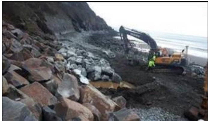
Ffig 35: Ail-lenwi'r creigiau ar ochr ddeheuol Cornel Friog, Gwynedd
